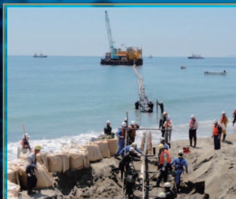
ケーブルの布設風景(函館側陸揚部)
