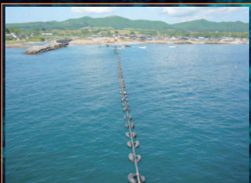
海底ケーブル布設のイメージ写真
