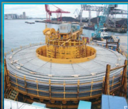
ケーブル布設船への積み込み風景
