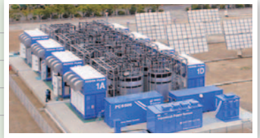
当社横浜製作所で実証運転中のレドックスフロー電池 (容量1MW×5時間)
