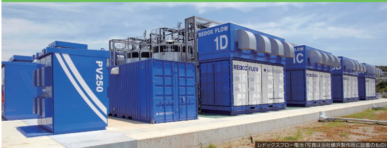
レドックスフロー電池 (写真は当社横浜製作所に設置のもの)
