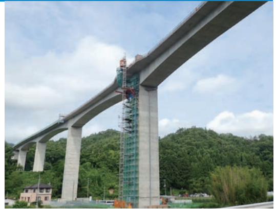
国道115号月舘高架橋上部工工事(写真提供:鹿島建設(株))
