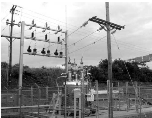
写真5 超電導ケーブルシステムと架空線との接続状況
