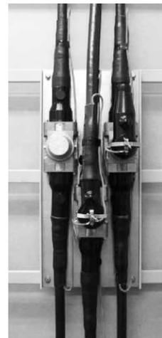
写真 3 分岐型接続装置
