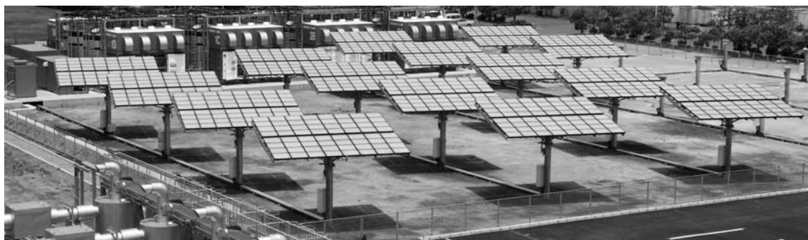
写真1 横浜製作所CPVシステム
