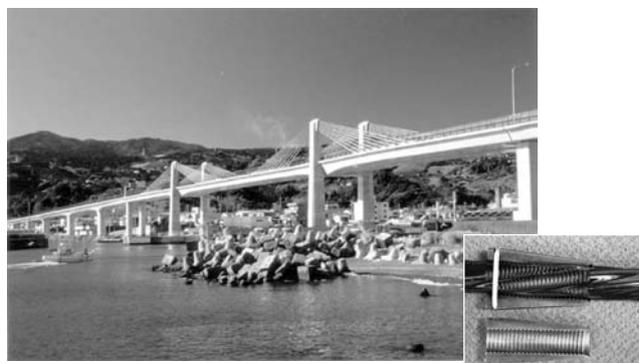
写真2 ECFストランドが最初に適用された小田原ブルーウェイブリッジ（写真提供：三井住友建設㈱）と開発された定着くさび
