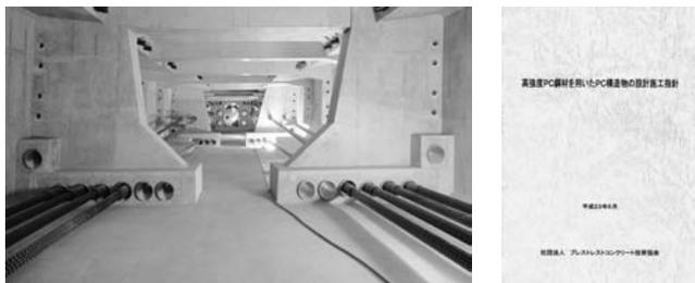
写真8 ECF高強度PCストランドによる外ケーブルを用いた橋梁の桁内状況とその適用指針（PC工学会）
