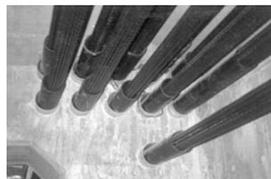
写真3 橋梁の箱桁内に配置されたECFストランドを用いた外ケーブル
