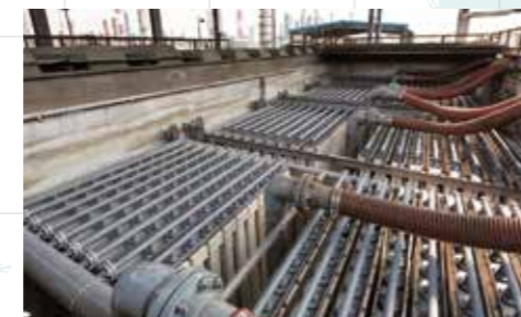
台湾大手石油精製企業に導入された水処理設備
