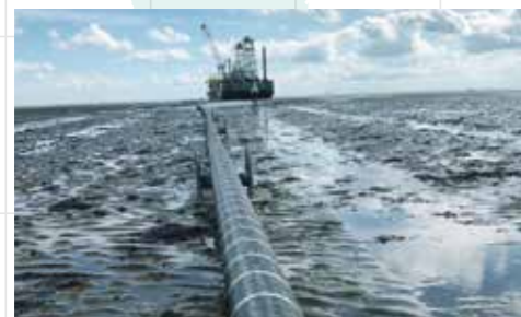
海底ケーブル布設の様子
