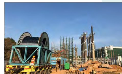
ケーブル布設の様子
