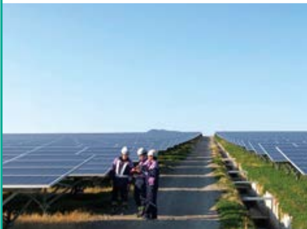
メガソーラーの施工のようす
