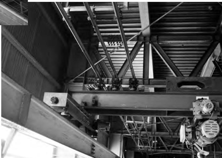
水平下向き布設例
