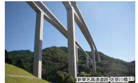
新東名高速道路;佐奈川橋※3 Sanagawa Bridge
