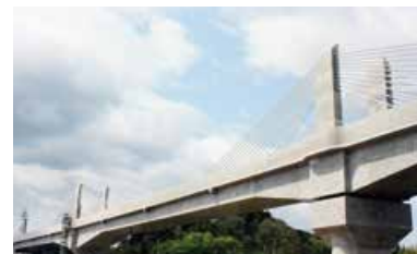
東北新幹線;三内丸山架道橋※4 Sannai-Maruyama Viaduct
