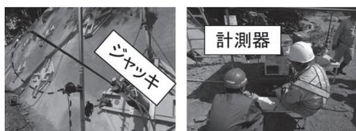
写真5 グラウンドアンカー工事における計測状況
